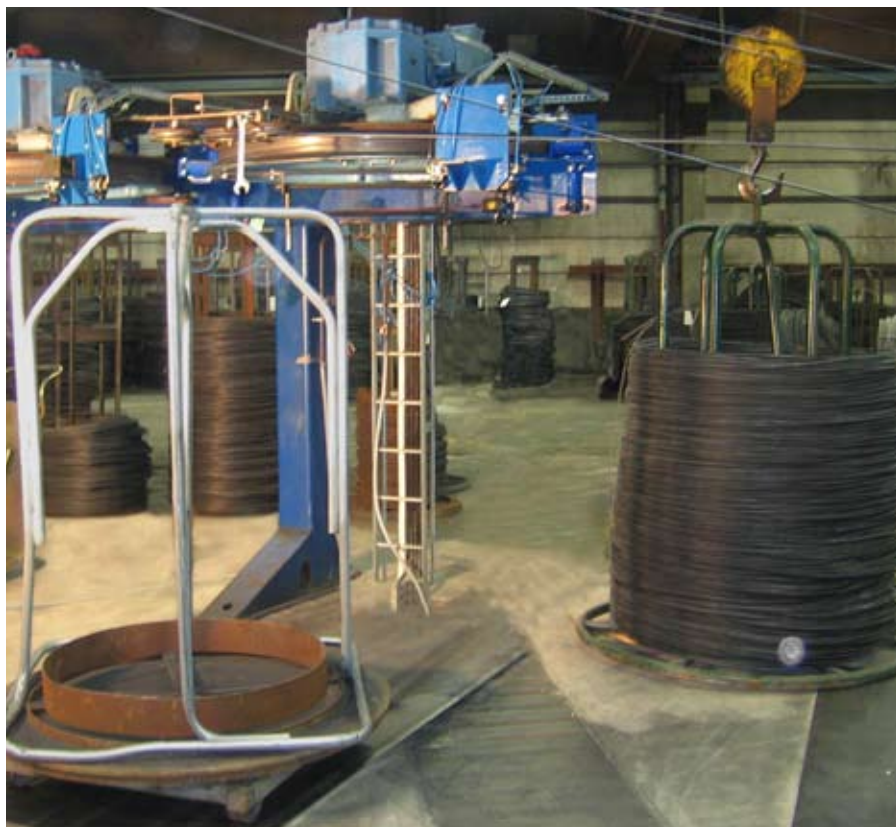
Nya framdragningsverket med fyra linjer
